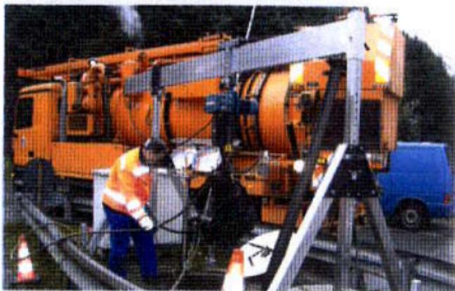
**Eines von vielen möglichen Einsatzfeldern des neuen Schnellbau-Portalkranes ist die Wartung und Reparatur von Pumpen.**
