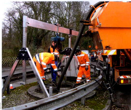
Das neue Portalkransystem lässt sich auch leicht an schwer zugänglichen Orten montieren.
